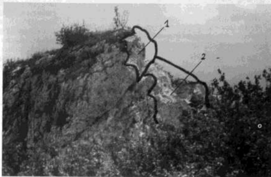
Fot. 1,2. Obszar zniszczeń widoczny od strony południowej (u góry) i południowo-wschodniej (na dole).
